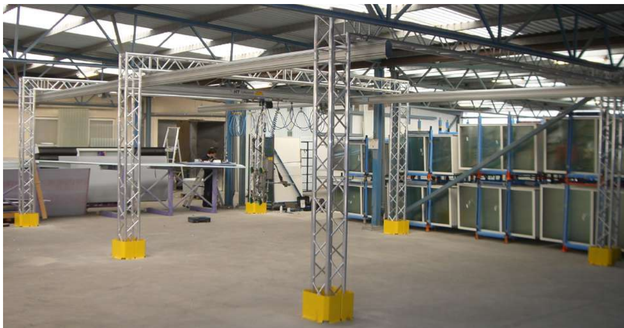
Skensystem med enkeltravers placerat i 3st. Trossbågar.
